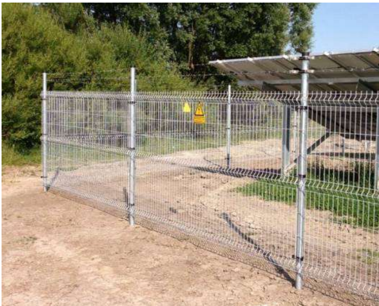
Abb. 10: Beispiel einer Zaunanlage 2,5 m Höhe inklusive Übersteigschutz
